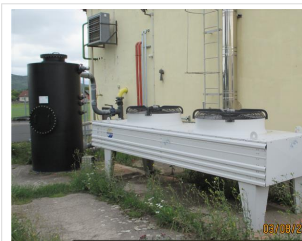
Tischkühler zu BHKW 2 / Aktivkohlefilter Selecta
