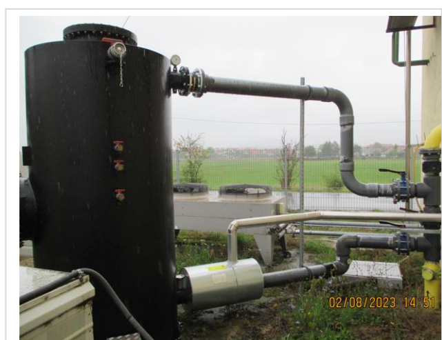
Tischkühler zu BHKW 2 / Aktivkohlefilter Selecta
