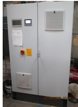
Exzentrerschneckenpumpe Vogelsang / Schaltschrank Flüssigfütterung
