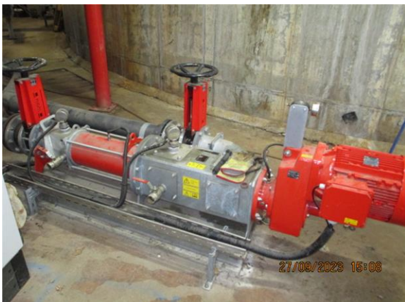
Exzentrerschneckenpumpe Vogelsang / Schaltschrank Flüssigfütterung
