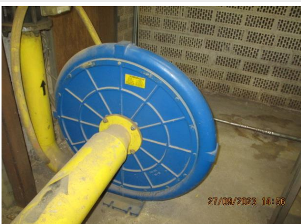
Gasgebläse Combimac / Gassack 318 m 3
