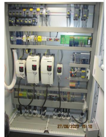
Exzentrerschneckenpumpe Vogelsang / Schaltschrank Flüssigfütterung
